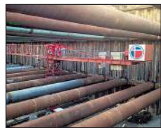
De mini-torenkraan. archief foto Avenue2
