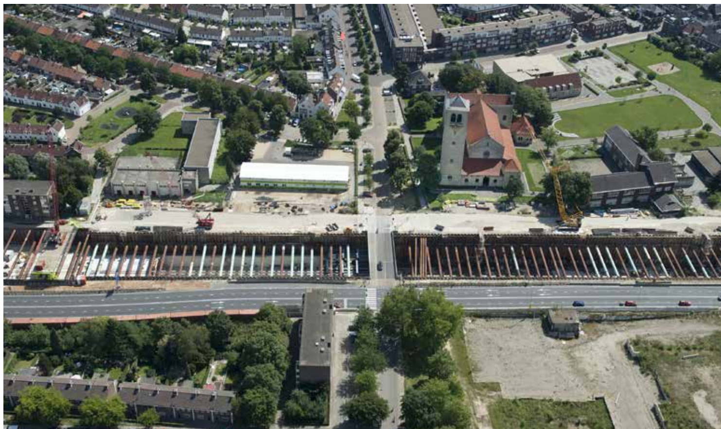
De tunnelwerkzaamheden reiken letterlijk tot in de voortuin van de Lourdeskerk. De tuinmuur is afgebroken. De stenen zijn genummerd voor herbouw (2014).
