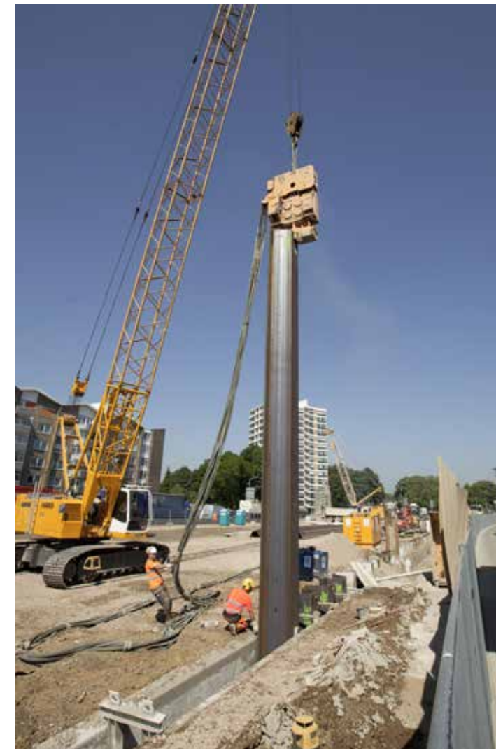
Het in- en uittrillen van damwandplanken was een piekmoment voor geluidshinder (2013).
