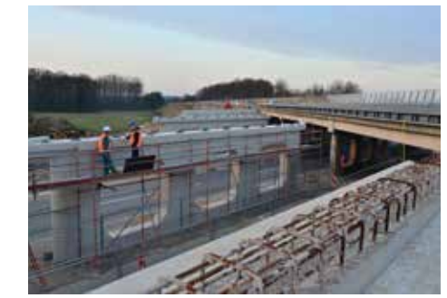
6 Kunstwerk kruising Kruisdonk – verbreding bestaand viaduct
