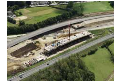
11 Fly-over A2/A79 – ‘vliegend’ viaduct dat naar zijn definitieve plek is geschoven
