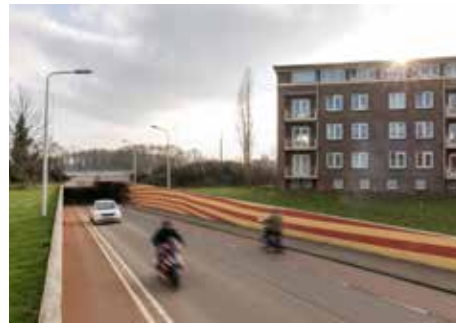
8 Verlenging tunnel Severenstraat
