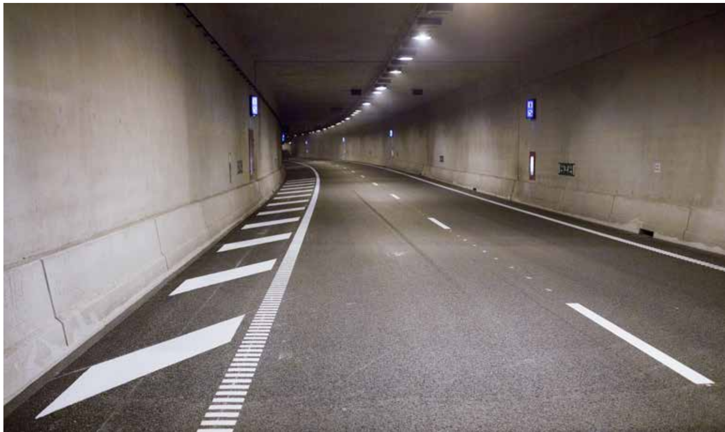
De bochten in de tunnel zijn verbreed voor een beter zicht. De verlichting hangt precies boven de middenstreep om te voorkomen dat automobilisten afwijken van de rijbaan (2016).
