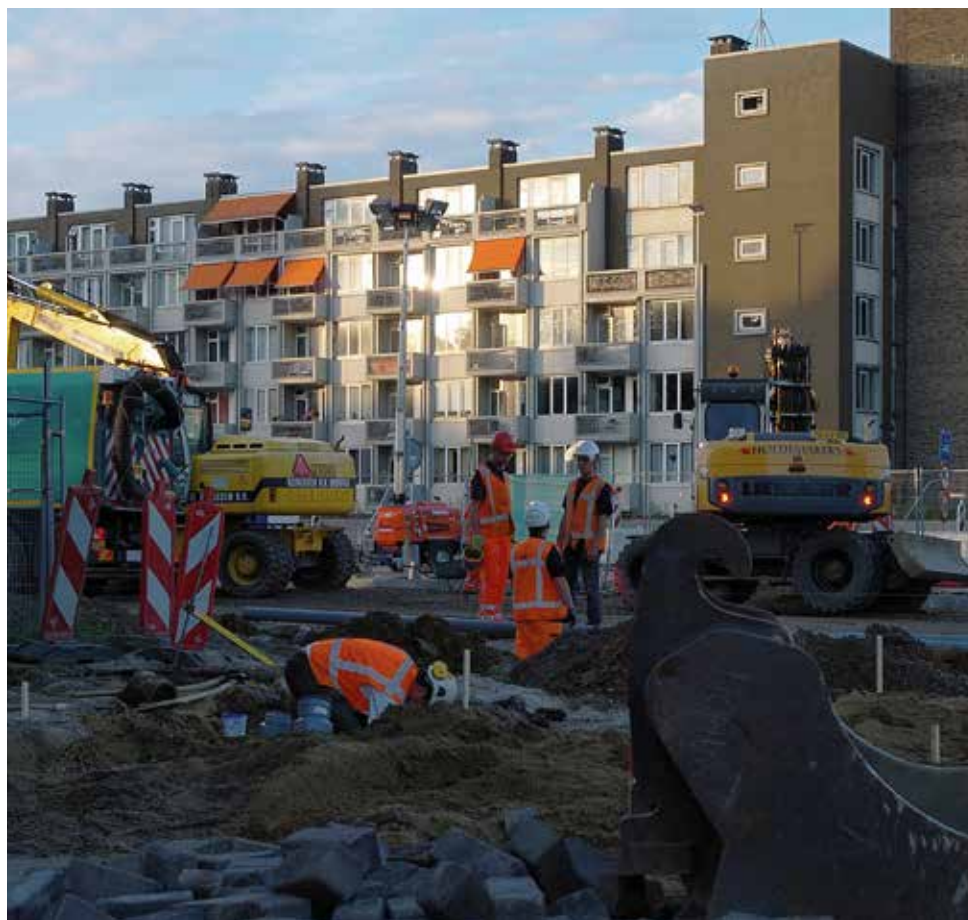
Verleggen van de N2 en kruispunt Scharnerweg (2012).
