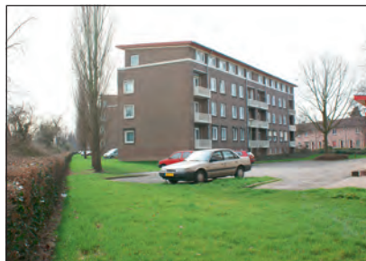
3. Nazareth, hoek Viaductweg
