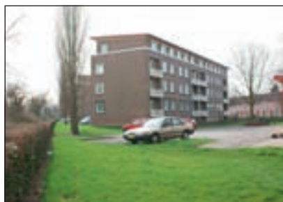
3. Nazareth, hoek Viaductweg
