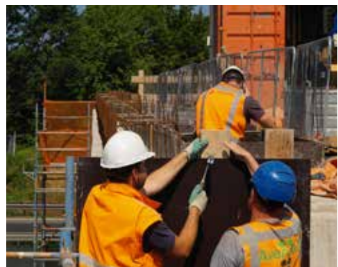
Verleggen tijdelijke N2 ^ Fietsbrug De Groene Loper v
