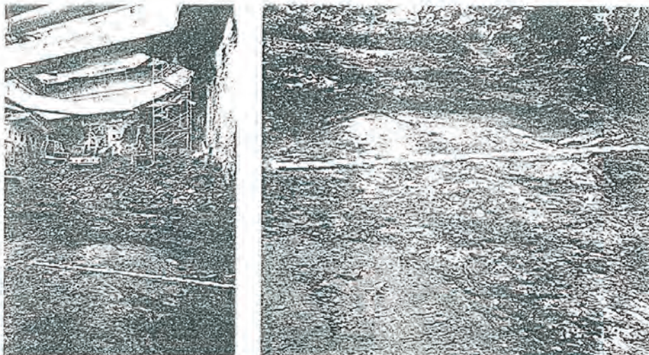
Abb. 14: SOILCRETE-Rostbalkenabschnitt, freigelegt
