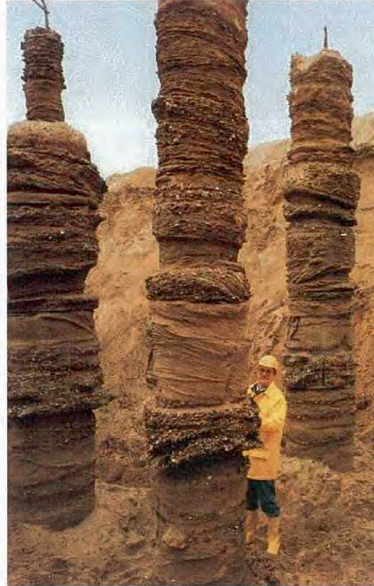
Bild 15: Foto von Düsenstrahlsäulen / DSV-Säulen (Firmenprospekt)
