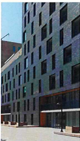
referentie geluidsluwe gevels
